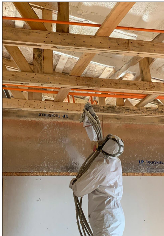
El poliuretano pulverizado se transforma luego en espuma aislante.
