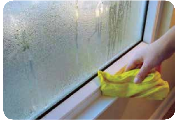
Figura 2.18: Condensación en ventana
