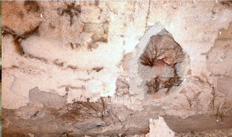
Liquen detrás de aislación interior
