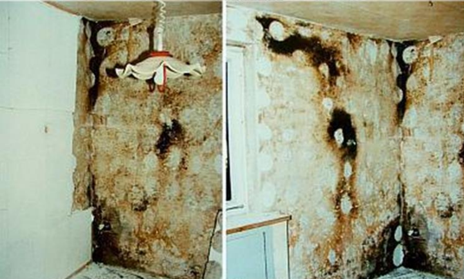
Moho detrás de aislación interior
