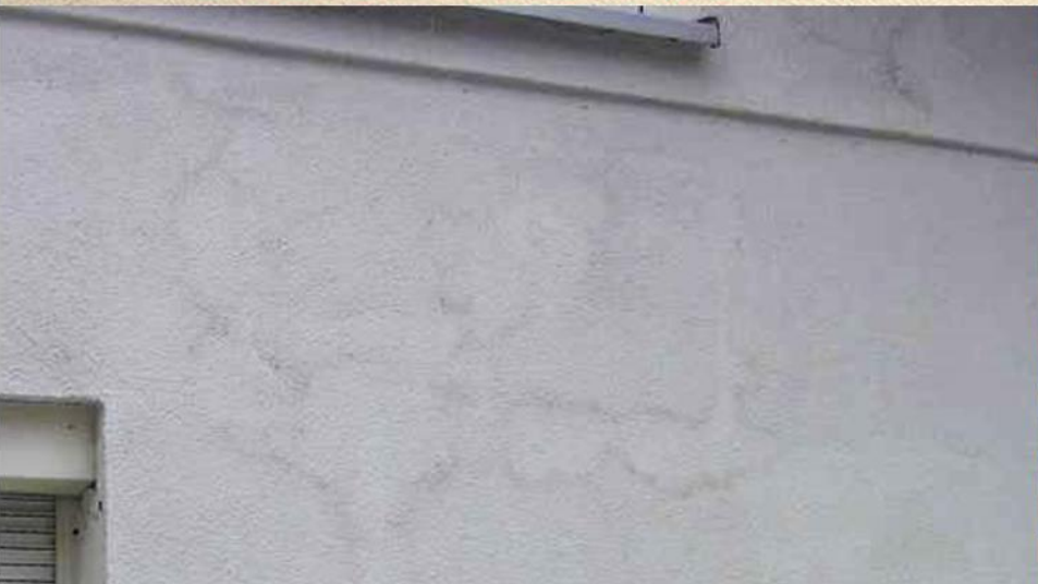
Entrada y acumulación de agua lluvia
