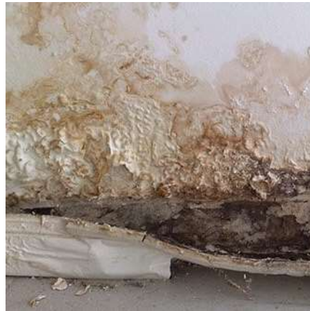
Humedad en muros
